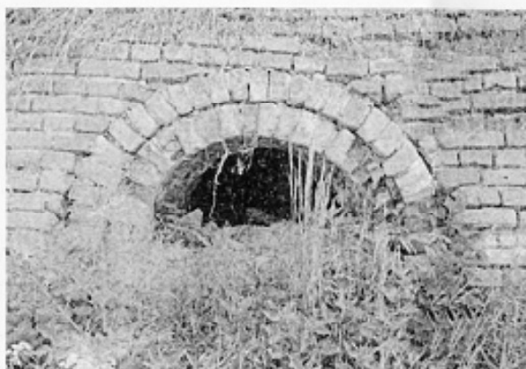
Einer der Eingänge zum Ringofen, der enttrümmert werden musste.
